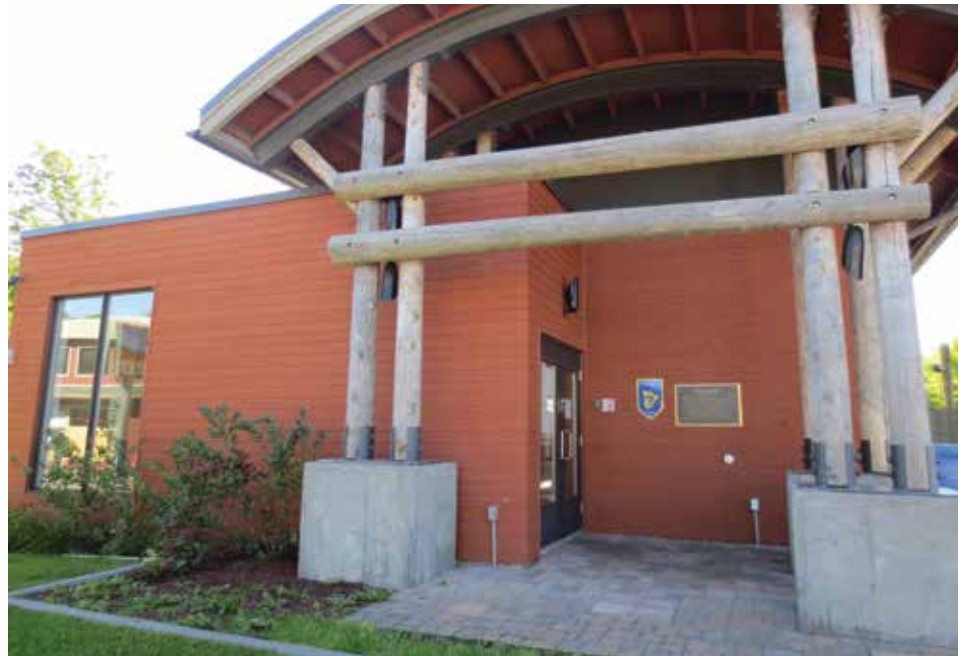
Le projet du Carrefour Artistique de Wendake sera réalisé dans l'ancien bâtiment de l'Office du Tourisme de Wendake.
